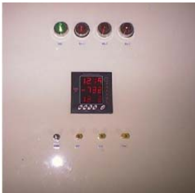
圖十九 控制箱面板配置圖
