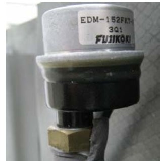
圖 6. 電子式膨脹閥
