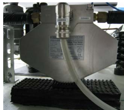
圖 7. 冷媒流量計
