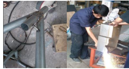
圖 7. 補強及電池盒製作
