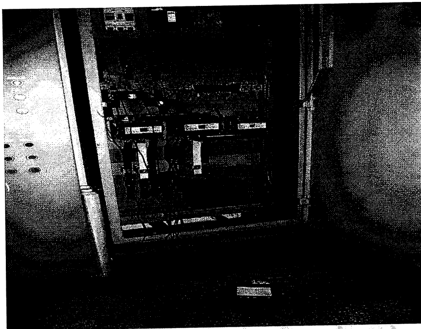
圖 3-19 舊有冰水主機電力量測
